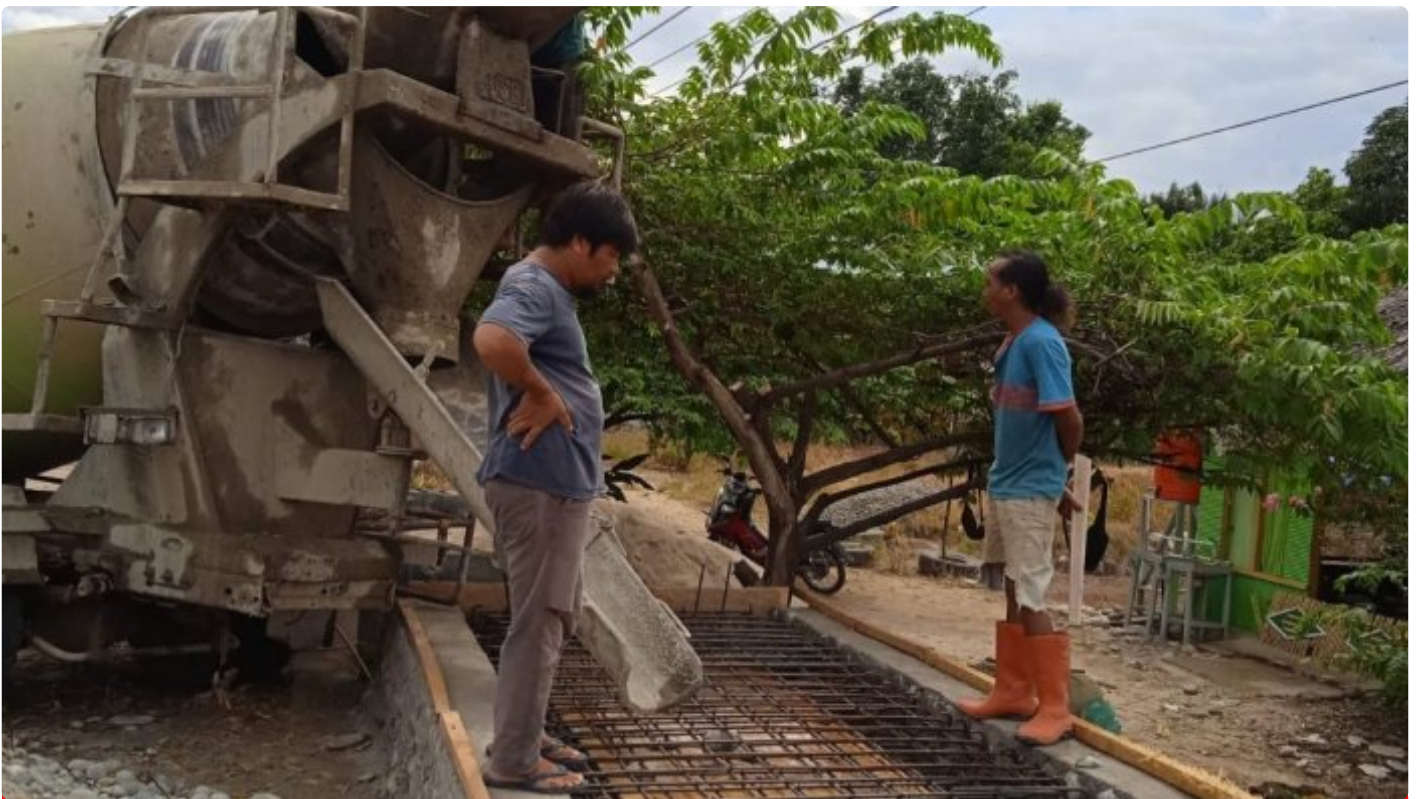
Pembangunan Plat Duicker Desa Mario, Kab. Luwu Utara
